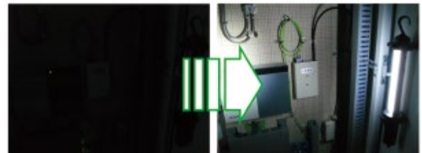
明かりを確保できない分電盤等の暗所作業に最適です。
